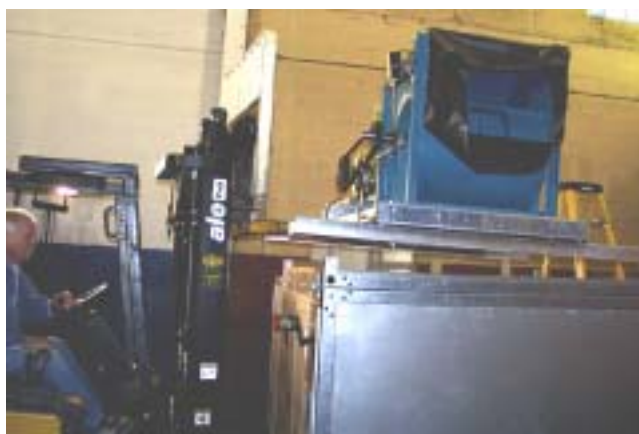
FIG. 10 - REMOVE FAN ASSEMBLY
