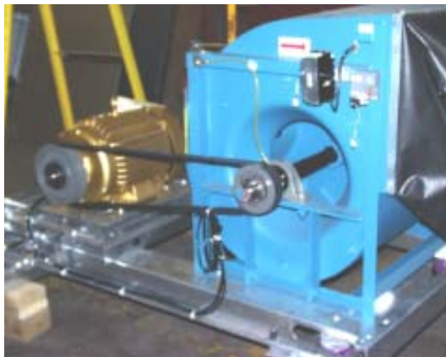
FIG. 9 - SECURE MOTOR WIRING
