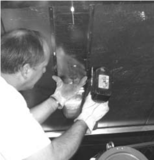
FIG. 17 - REMOVE WIREWAY
