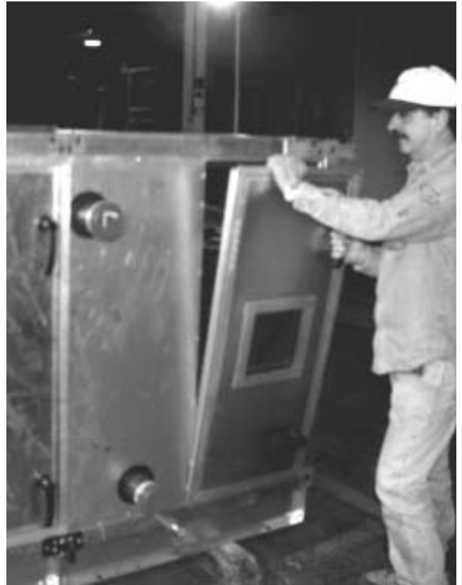
FIG. 3 - REMOVE DOOR ASSEMBLIES
