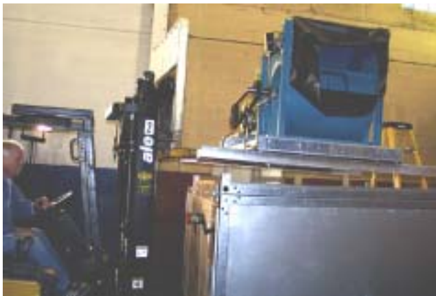
FIG. 10 - REMOVE FAN ASSEMBLY
