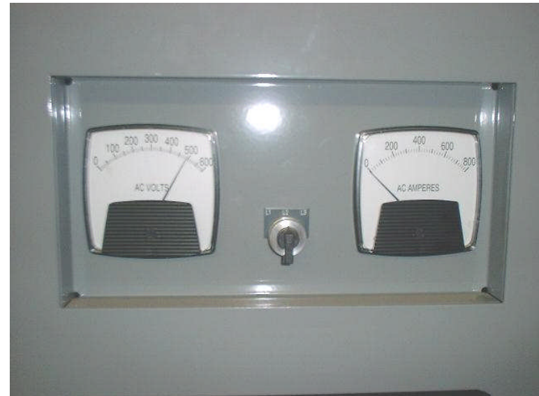
Optional Control Center Volt Meter and Ammeter
